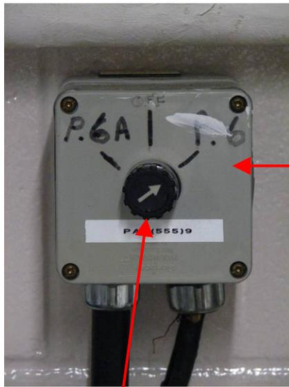
Interrupteur des pompes
